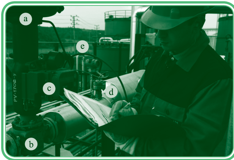
Figura 7.2: Válvula de Controle instalada: (a) Atuador pneumático; (b) Elemento obturador; (c) Transmissor; (d) Sensor; (e) Ar comprimido.
