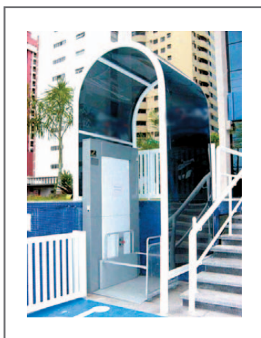
Figura 2 – Plataforma para pequenas elevações (Acessibilidade)
