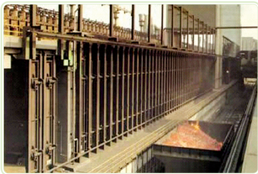
Figura 1.2: Bateria de coque
