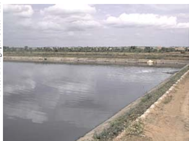
Foto 01 – Estação de Tratamento de Esgoto Sanitário
