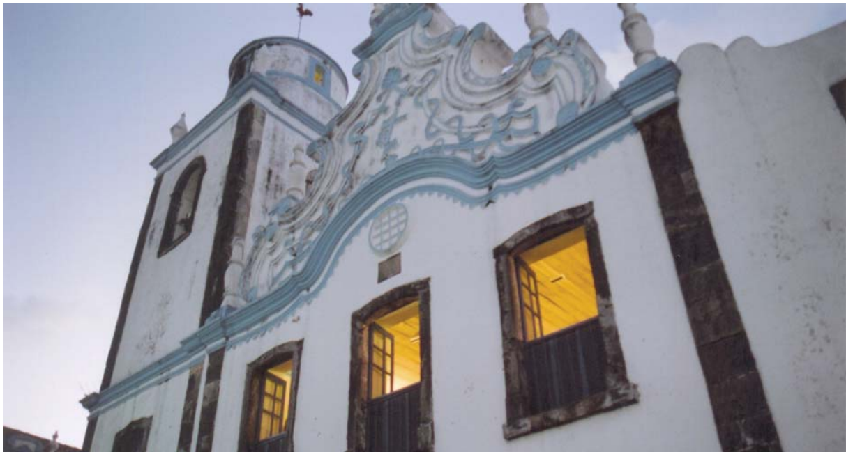
Fachada da Igreja de Santo Antônio dos Militares
