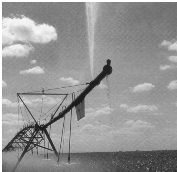
Figura 06: Pivô Central: Projeto de Irrigação do Baixo Açu (RIO GRANDE DO NORTE, 2000)
