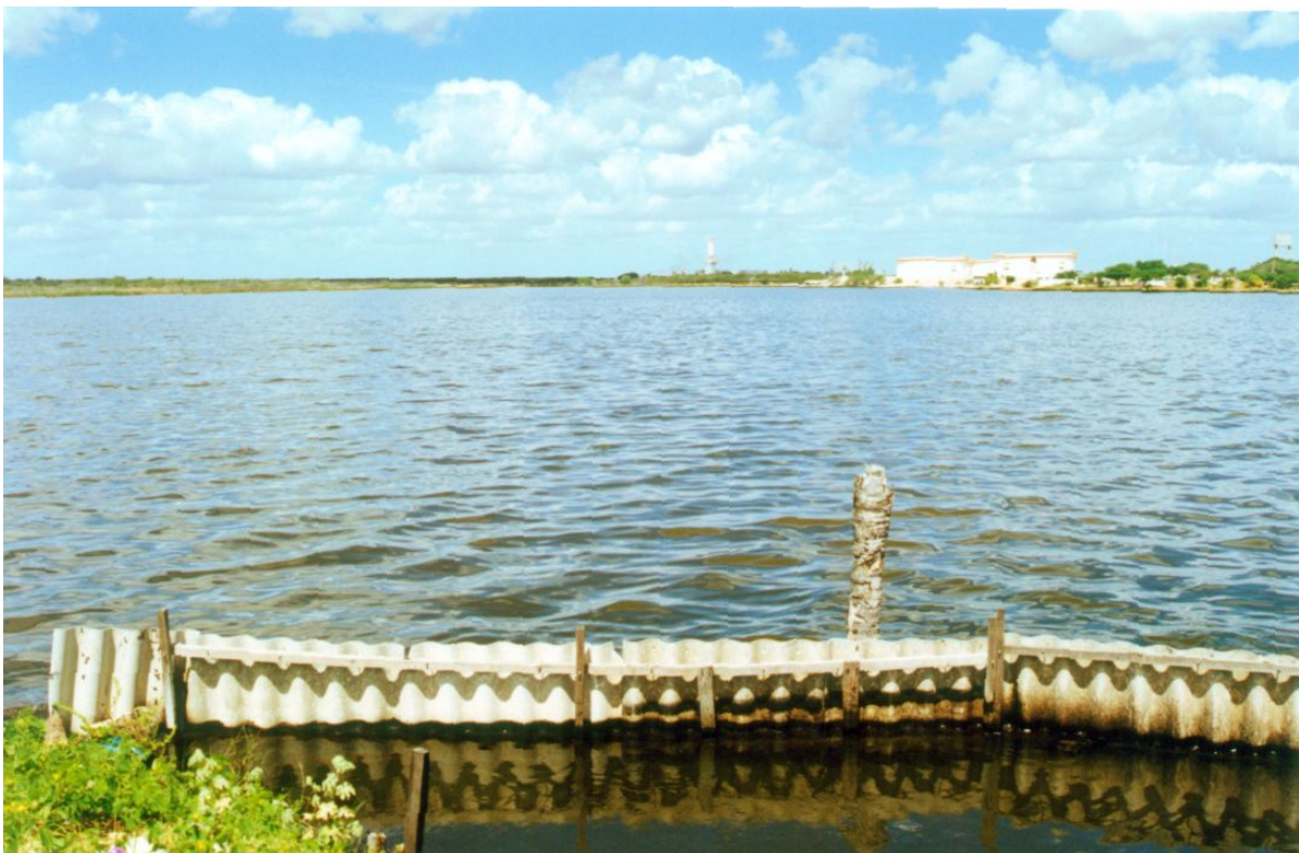
Foto 1 - Vista da Lagoa de Baixo a partir do vertedouro, ao fundo a direita vê-se os tanques de armazenamento de petróleo do Pólo Industrial de Guamaré.
