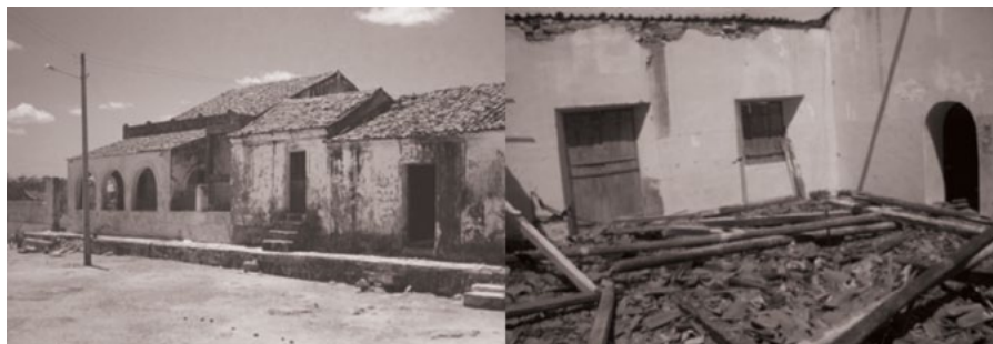
Fotografia 73 e 74: Ruínas da casa do Barão de Serra Branca.
