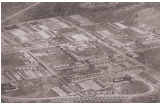
Fotografia 64: Edificação da nova São Rafael.
