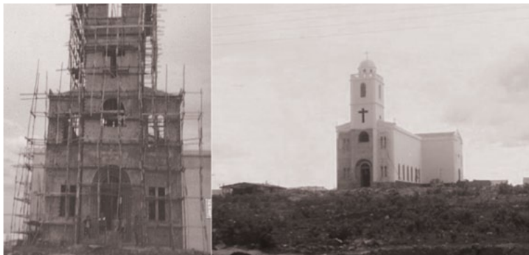
Fotografia 65 e 66: À esquerda, construção da igreja da nova São Rafael (jan./1983). À direita, etapa final da construção da igreja da nova São Rafael.
