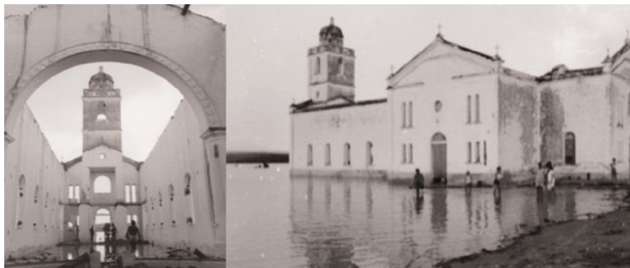
Fotografias 56 e 57: À esquerda, Interior da igreja (inundação da velha São Rafael). À direita fachada lateral da igreja (inundação da velha São Rafael).
