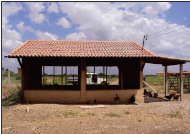
Figura 10: Galpão de alvenaria
