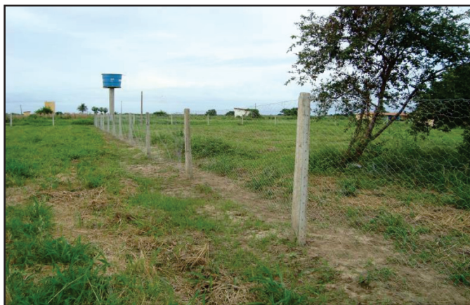
Figura 12: Cerca com tela de arame galvanizado e estacas de concreto.
