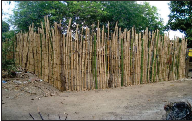
Figura 13: Cerca construída com bambu.
