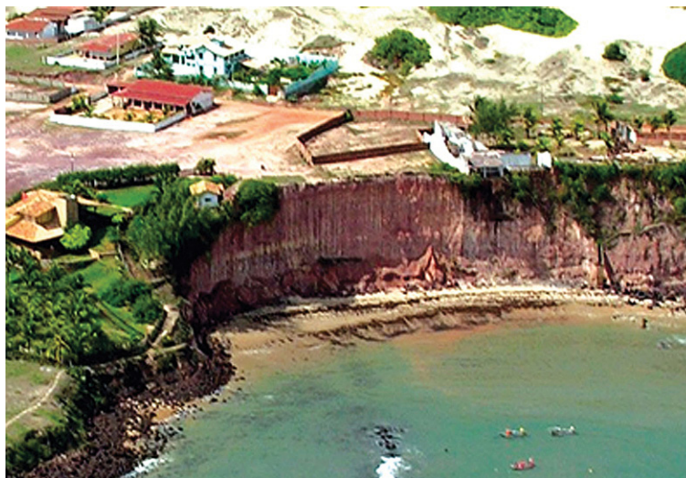
Figura 3 – Fotografia mostrando falésia marinha ativa, com de ocupações antrópicas instaladas muito próximas às suas bordas, inclusive com registro de desabamento no sopé da falésia. Foto: Diniz, 2008.
