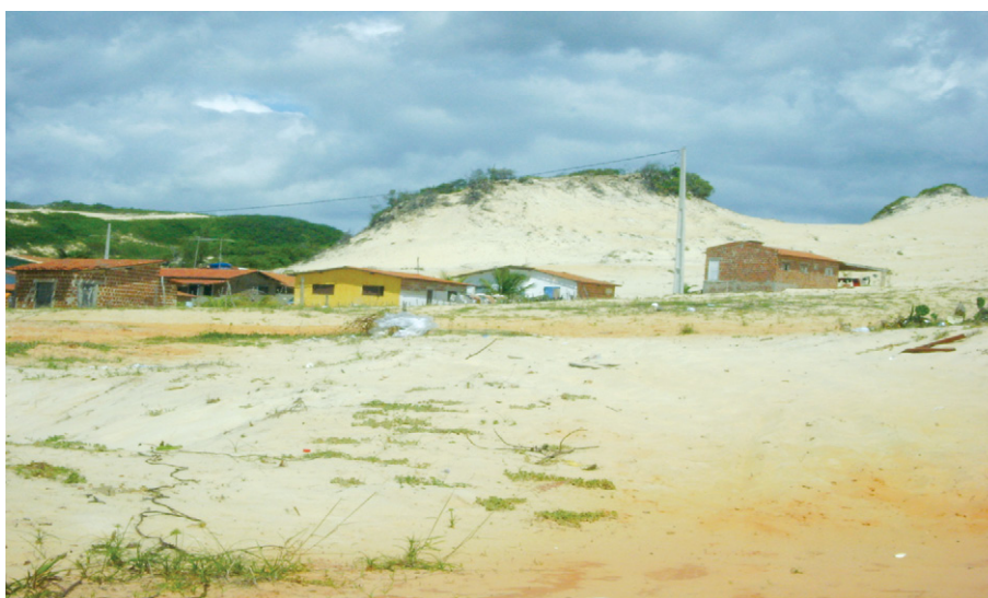
Figura 12- As casas são construídas no “pé do morro” e sofrem com a ação dos ventos e a falta de infra-estrutura.
