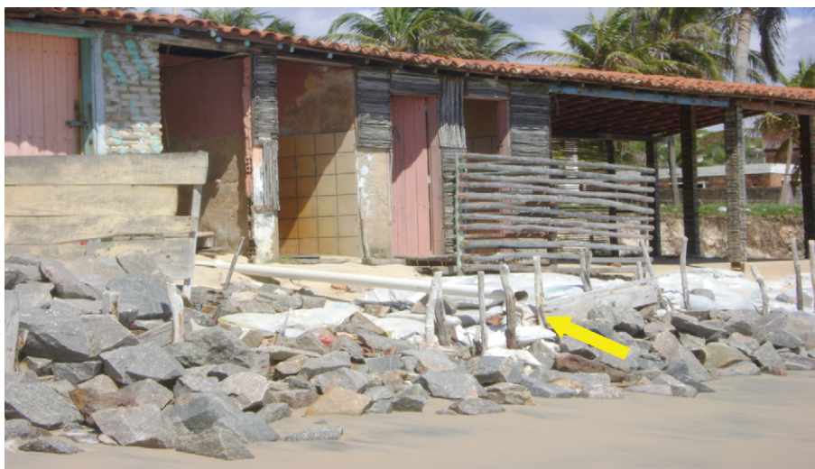
Figura 7- Barraca sem tratamento de esgotos e tubulação exposta. Fonte: Autora, 2009.
