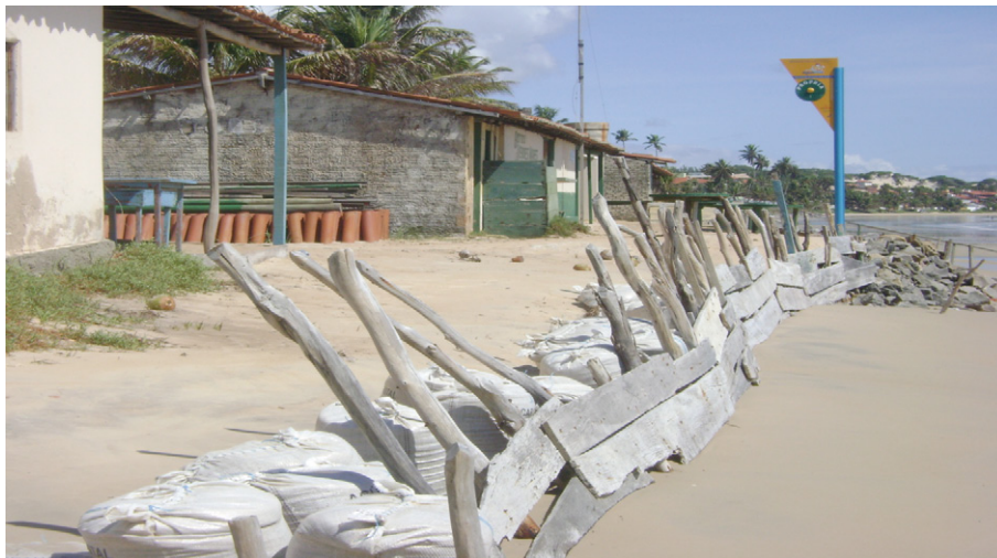
Figura 9- Barricadas de proteção contra a ação das marés. Fonte: Autora, 2009.
