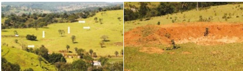
**Figuras 6.79 e 6.80** – Visão geral das barraginhas instaladas e distribuídas ao longo do terreno em área de pastagem (esq.) e em detalhe (dir.).
