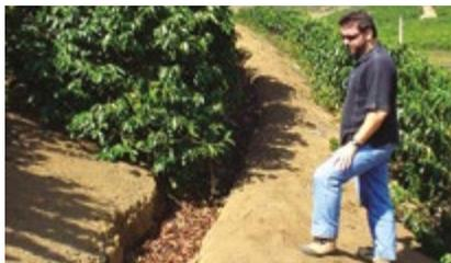
**Figura 6.74** – Valeta aberta na terra para reduzir a velocidade da água da chuva.
