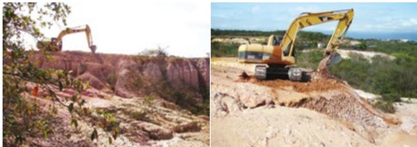
**Figuras 6.109 e 6.110** – Detalhes da suavização das paredes da voçoroca.
