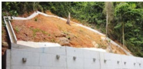
**Figura 6.87** – Canaleta na parte de cima do talude de contenção e escada de dissipação de cimento nas laterais para desviar e conduzir a água da chuva e reduzir sua velocidade.
