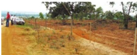
**Figura 6.90** – Detalhe de terraço acompanhando o declive, desviando a água da estrada para a área do lado direito, de forma que a enxurrada seja distribuída pela superfície do terreno que apresenta pequena declividade.
