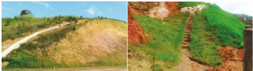
**Figuras 6.85 e 6.86** – Canaleta de cimento (esq.) e de bambu (dir.) para desviar a água em taludes.
