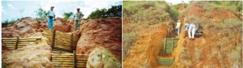
**Figuras 6.83 e 6.84** – Paliçadas de bambu em encostas íngremes que apresentam voçorocas.
