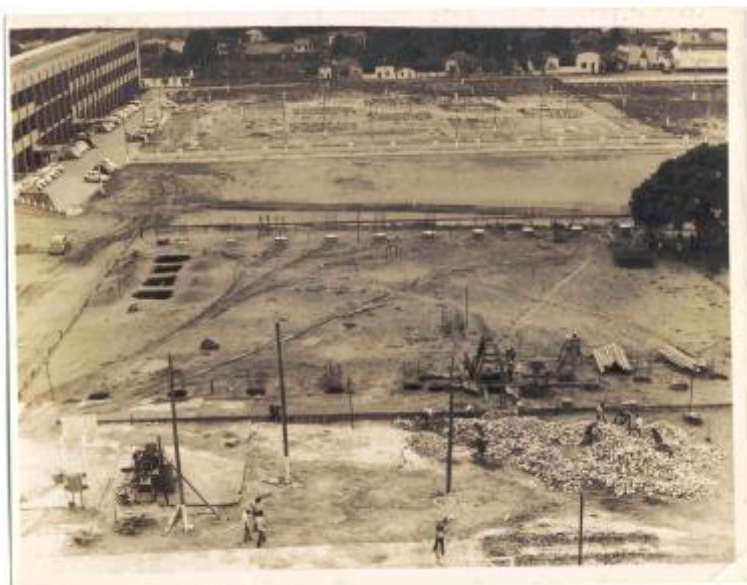
Construção CEFET-RN Fonte: Arquivo CEFET RN
