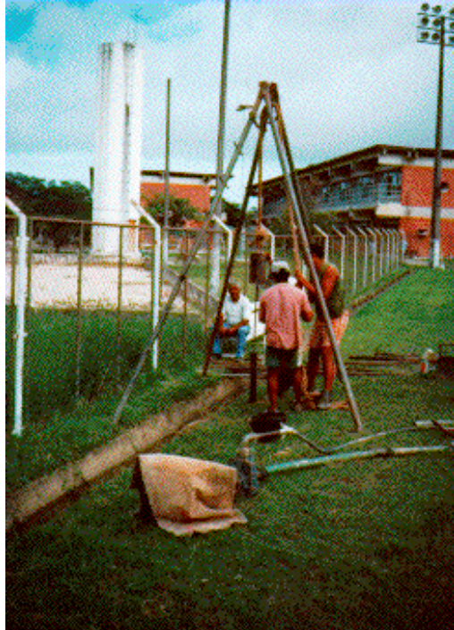
Figura 3.6- Execução do ensaio SPT nas proximidades do local de estudo.
